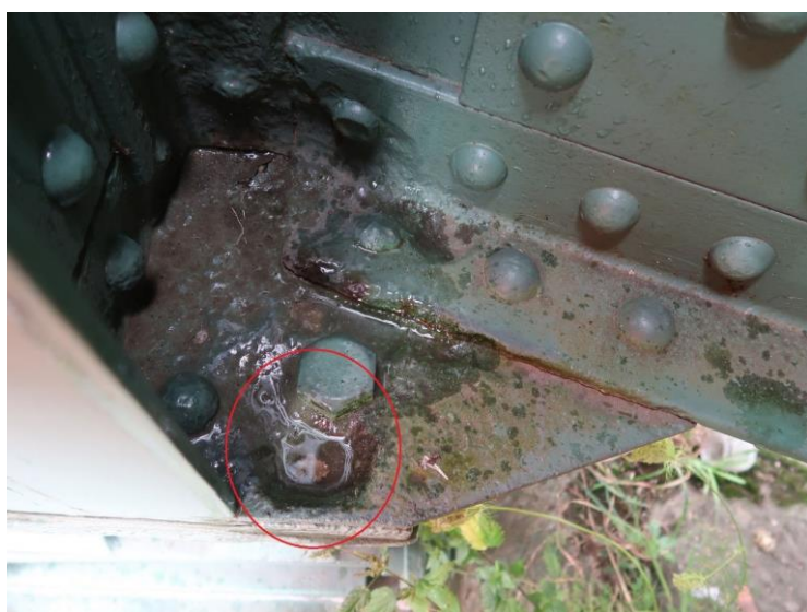
Konstrukce K 01: hlavní nosník vlevo – prokorodovaný styčnickový plech na začátku
