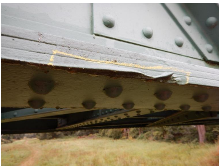
Konstrukce K 03 hlavní nosník vpravo – vryp v dolní pásnici v 7. příhradě
