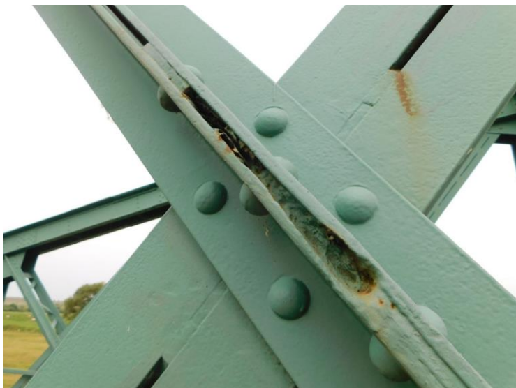
Konstrukce K 02 hlavní nosník – štěrbínová koroze na diagonále
