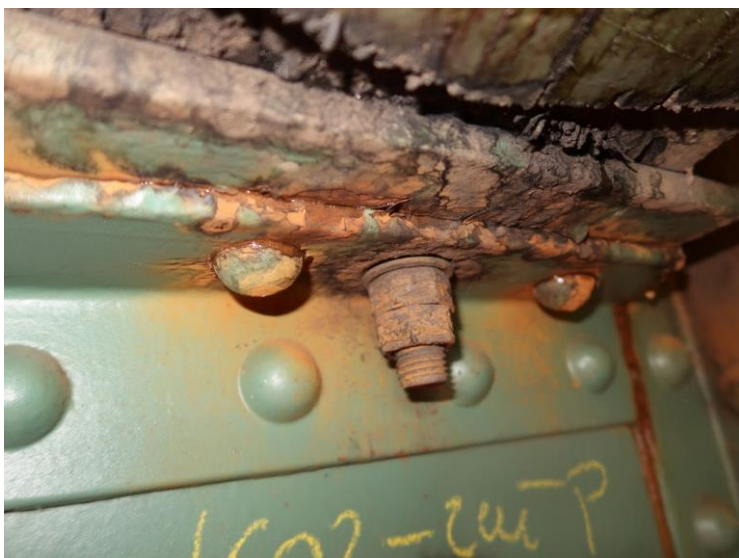
Konstrukce K 02 podélník vpravo – volné nýty na začátku
