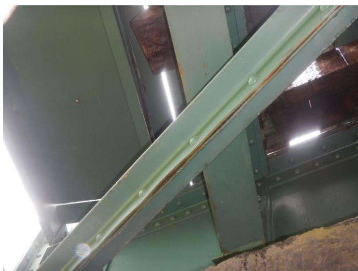
Konstrukce K 01 dolní podélné ztužení – štěrbinová koroze
